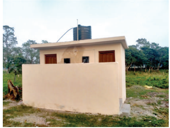
सार्वजनिक शौचालय निर्माण
