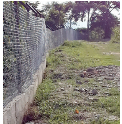
नन्दभाउजु उपभोक्ता समितिमा मानव बन्यजन्तु द्वन्द्व न्यूनीकरणका लागि पर्खा सहितको मेशजाली निर्माण
