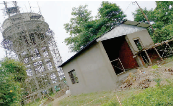
कोल्हुवा खानेपानी तथा सरसफाई उपभोक्ता समितिको कार्यालय भवन निर्माण
