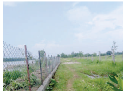
कालाबञ्जर उपभोक्ता समिति पि.सि.सि. सहितको मेसजाली निर्माण
