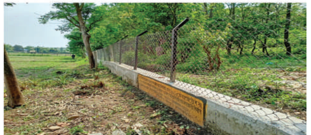
त्रिबेणी उपभोक्ता समिति क्षेत्रमा र नन्दभाउजु उपभोक्ता समिति क्षेत्रमा निर्माण गरिएको पि.सि.सि. सहितको मेषजाली निरीक्षण गदै प्राविधिक
